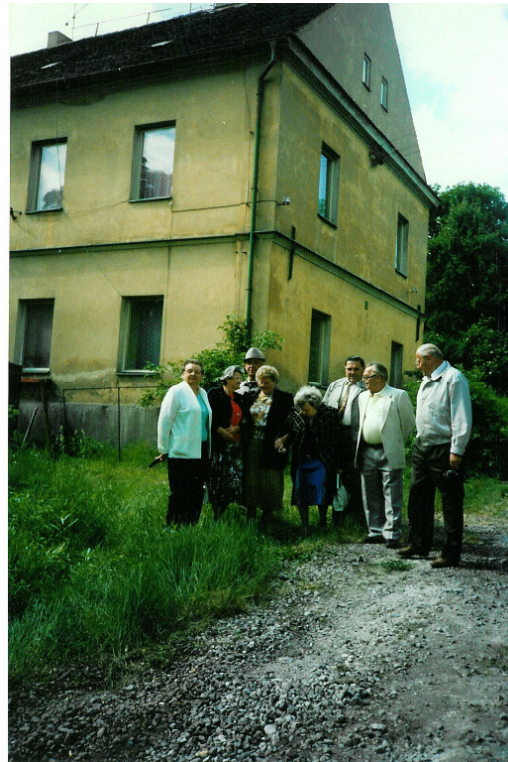
1991: Die Schule steht trotz damaliger gravierender Baumängel immer noch.
